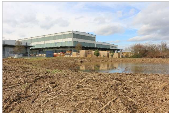
8) Regenrückhaltebecken © Klärle GmbH, 13.03.2023
