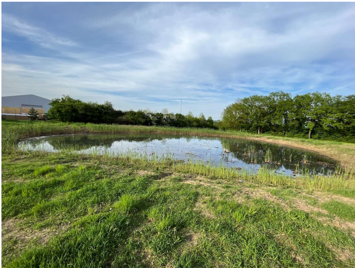
Regenrückhaltebecken © Klärle GmbH, 09.05.2023
