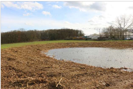
7) Regenrückhaltebecken mit neuem Wall © Klärle GmbH, 13.03.2023
