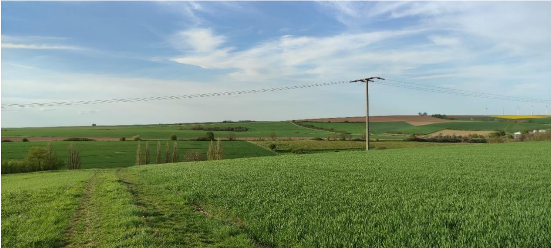
Abbildung: 20 KV-Leitung im südlichen Teilgebiet
