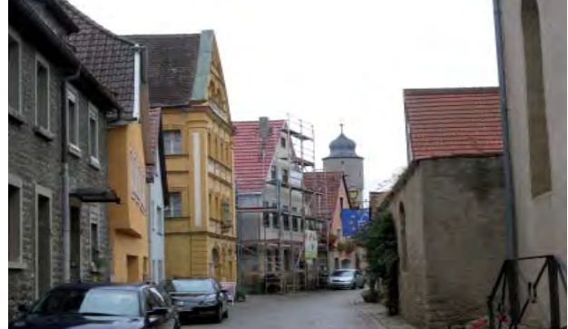
Sanierungsarbeiten in der Altstadt
