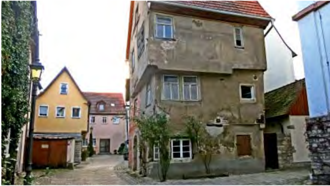
Sanierungsbedürftiges Haus in der Ochsenfurter Altstadt
