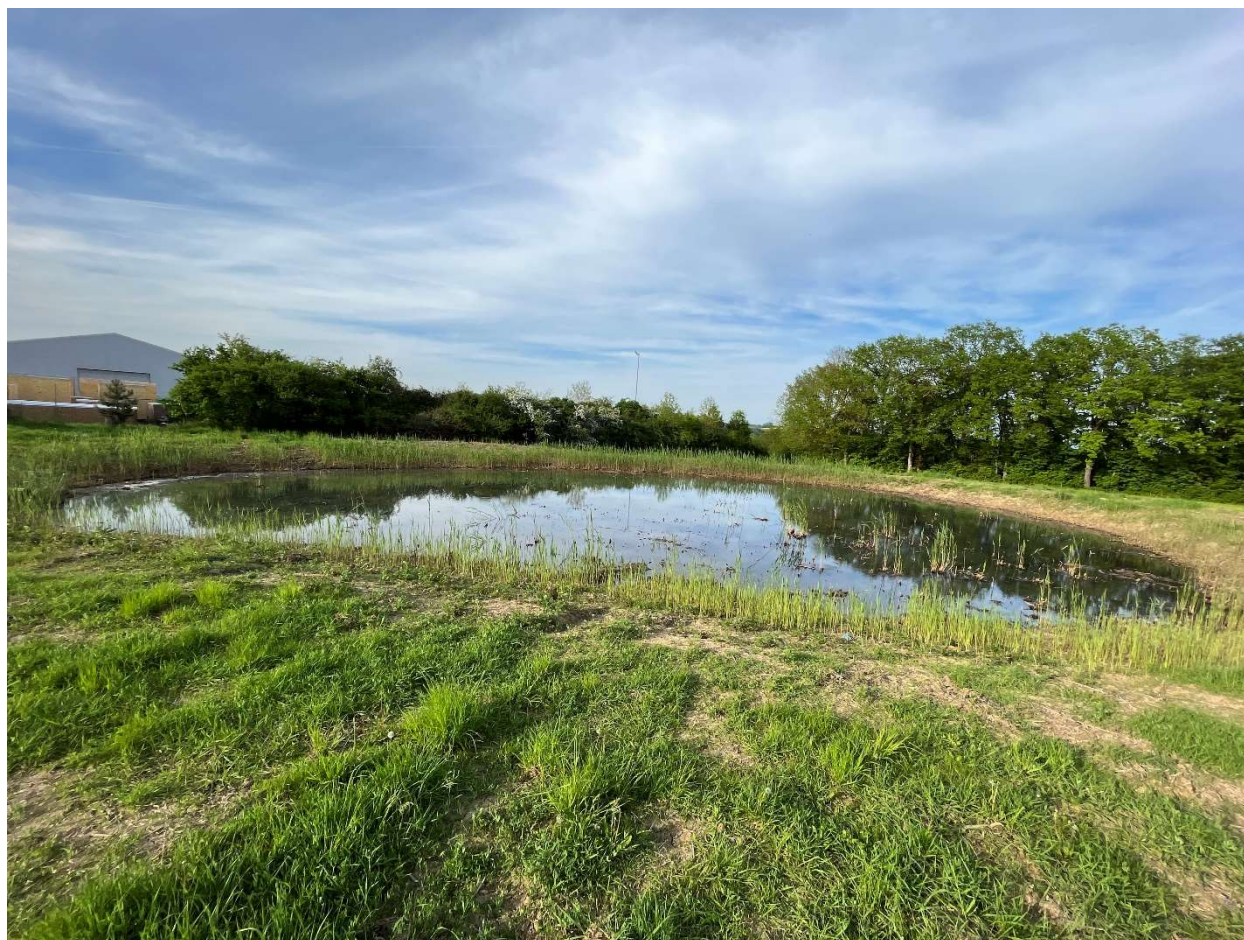
Regenrückhaltebecken © Klärle GmbH, 09.05.2023
