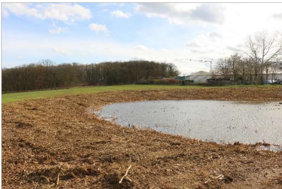
7) Regenrückhaltebecken mit neuem Wall © Klärle GmbH, 13.03.2023
