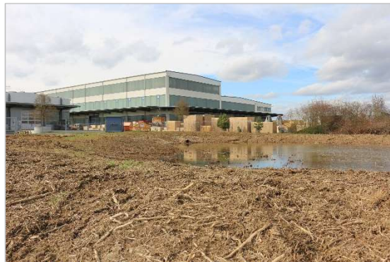
8) Regenrückhaltebecken © Klärle GmbH, 13.03.2023
