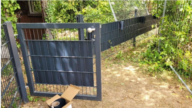
Montage von Sichtschutzstreifen am Stabgitterzaun als Überkletterhindernis
